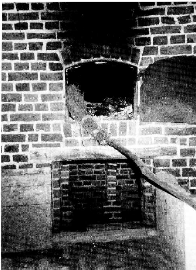
Detail van de ovenmond met onderliggende kelder in het bakhuis van Braos.
